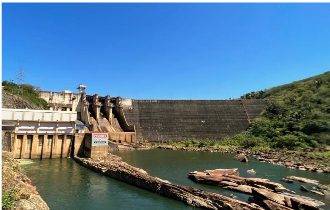
Figura 1 – Barragem da UHE Santa Clara
